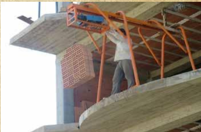
حمل مصالح بدون رعایت اصول فنی و ایمنی
