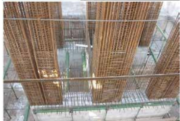
شکل (۲): سوپروال یا دیوار برشی مرکزی
