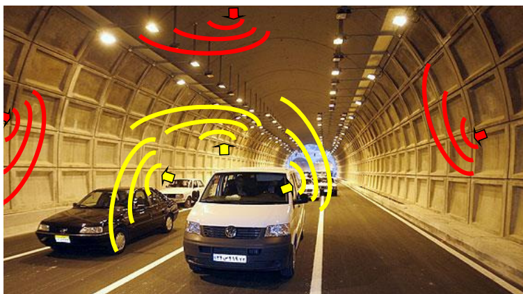
شکل ۱۲: سطوح سخت و صاف بتنی منعکس کننده امواج صوتی و عامل پدیده تشدید
