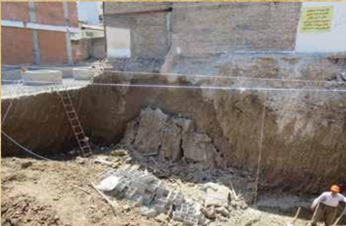
عدم اجرای سازه نگهدارنده در گودبرداری و ریزش ناشی از گودبرداری
