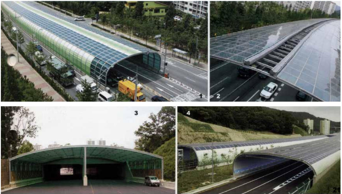
شکل ۸: تونل های جاذب صوت که قادر به جداسازی کامل صوتی یک مسیر می باشند
