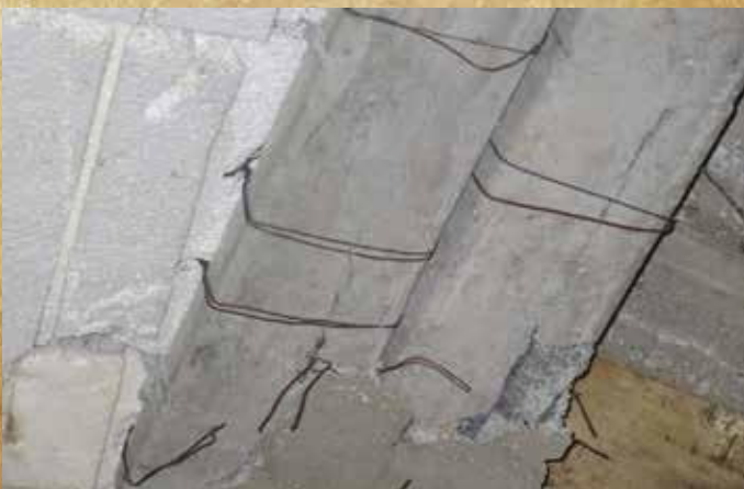
استفاده از تیرچه های با کیفیت فنی نامناسب در اجرای سقف
