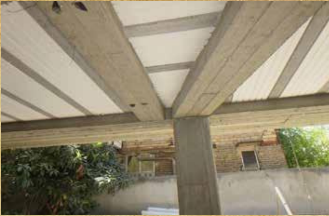
اجرای نامناسب تیر سقف و عدم ارتباط با ستون
